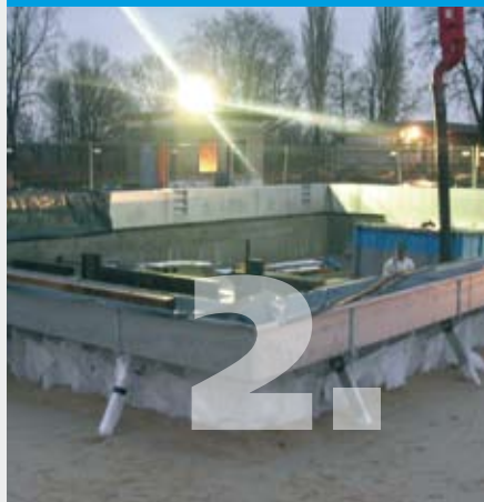
Montage der Beckenwände auf der Baustelle
