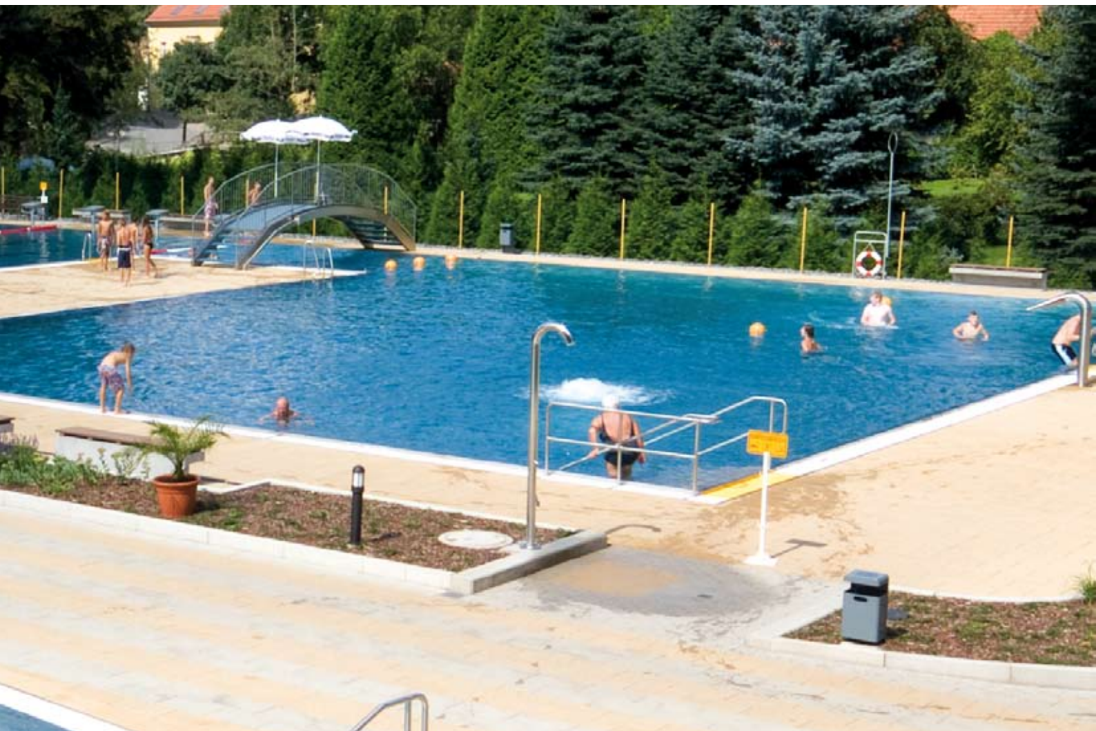
Fertige Beckenwand mit Nischenleiter
