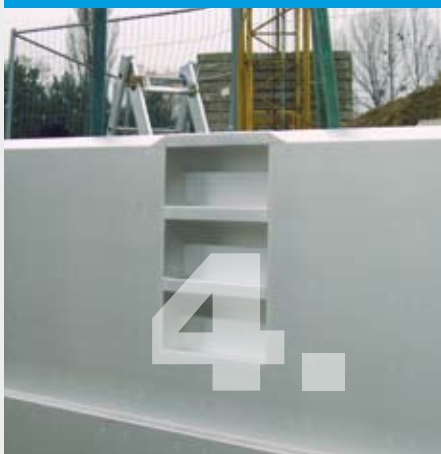
Fertige Beckenwand mit Nischenleiter
